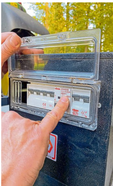
Fehlerstromschutzschalter, hier kombiniert mit einem Leitungsschutzschalter, sollen die Anwender vor Stromunfällen schützen.
